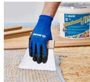
**Weniger Gewicht, mehr Reichweite bei der Parkettverlegung: Mit Ultrabond Eco S Lite führte Mapei seinen ersten SMP-Klebstoff mit Leichtfüllstoffen ein.**
