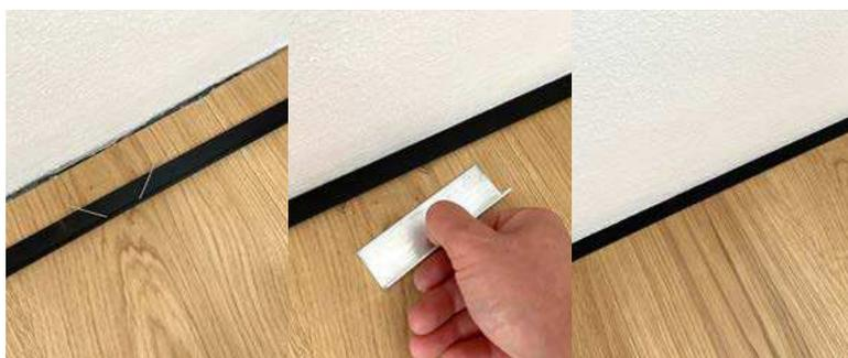
**Mit der Montagehilfe lassen sich Clipse und Abschlussleisten in wenigen Schritten anbringen.**
